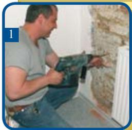
Die **ÖNORM B 3355** nennt die DARR-Methode als das einzige Verfahren, das präzise die im Mauerwerk gebundene Feuchte misst.
